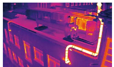
Surveillance de température dans la thermographie du bâtiment
