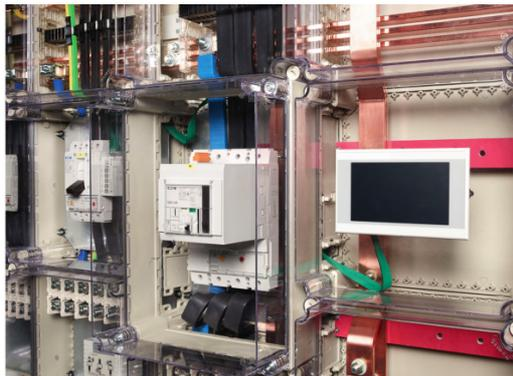
**Image 2 :** Eaton assure l'intégralité du pré-montage mécanique, rails cuivre destinés au système de distribution électrique modulaire CI compris.
