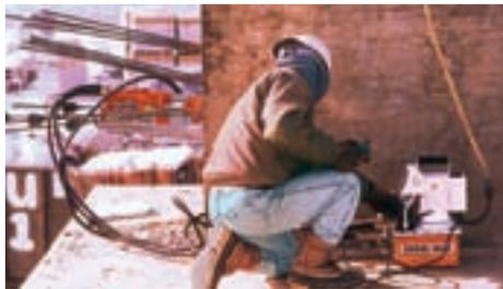
Modèle PE60 utilisé pour une mise en tension.
