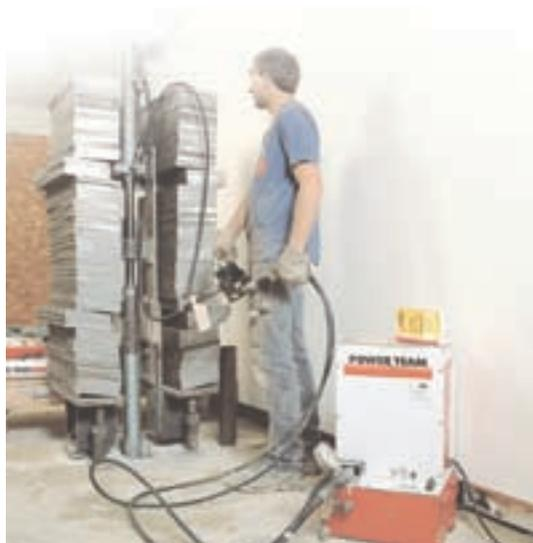
Pompe PQ603 et vérin C256C utilisés lors d'une opération de levage et de stabilisation des fondations d'un bâtiment.
