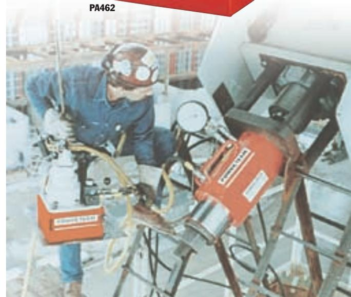
Pompe PA554 et vérin à orifice central RH2008 utilisés pour une mise en tension de câbles.
