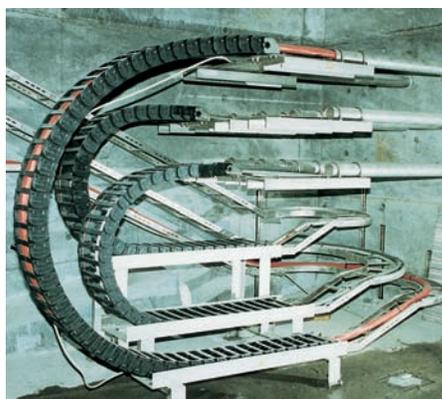
La gamme igus® offre jusqu'à 12 rayons courbure par Série de Chaîne sur demande. Ici, le projet de pont Storebaelt
