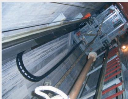
E2/000 - Grande stabilité même sous exposition en continu à des courants d'air ainsi que des mouvements pendulaires dans cet ascenseur de 160 m de haut.
