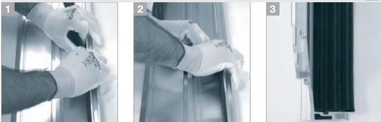
Couper le profilé en caoutchouc à la longueur de la goulotte (longueur standard de 2 m) et le presser à la main dans la rainure prévue à cet effet. (Photo : côté gauche. Inverser pour le côté droit. Répéter l'opération pour tous les tronçons)
