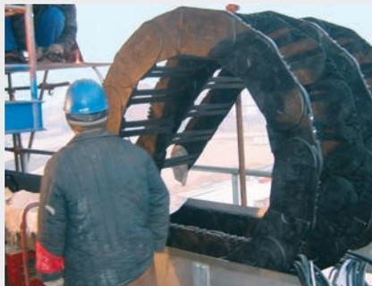
Montage d'une Chaîne Porte-Câbles E4.1 série 800 dans une goulotte en acier igus®.
