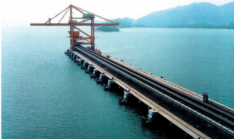
Course glissante (plusieurs Chaînes Porte-Câbles en relais) de 441,3 m réalisée avec une Rol E-Chain® Série 5050R d'igus®
